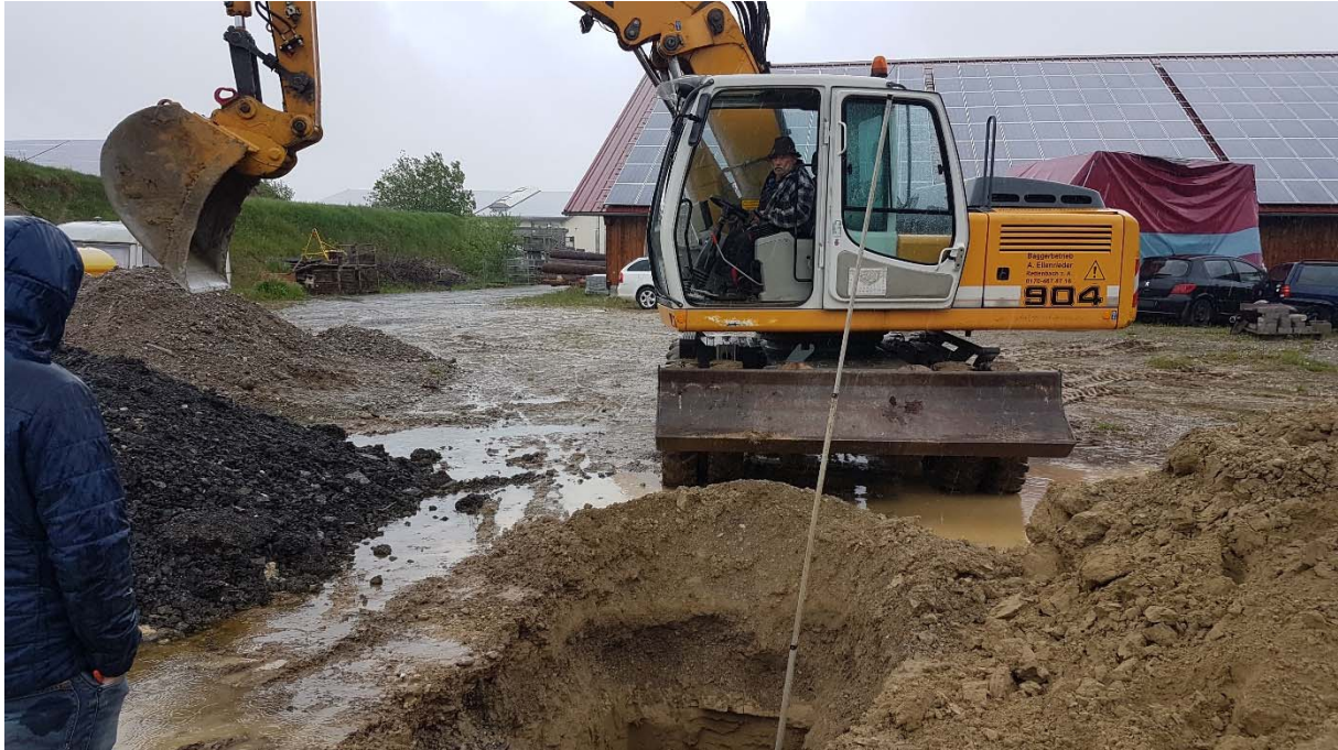
Bild 1 - Ansatz Schurf 1
